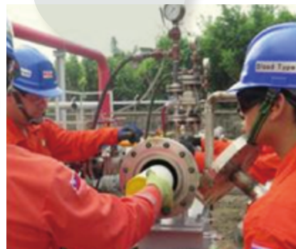
智慧型通管器檢測過程
