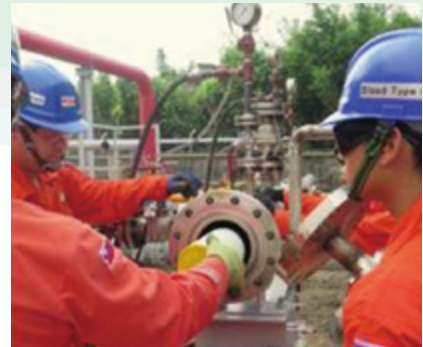
智慧型通管器檢測過程
